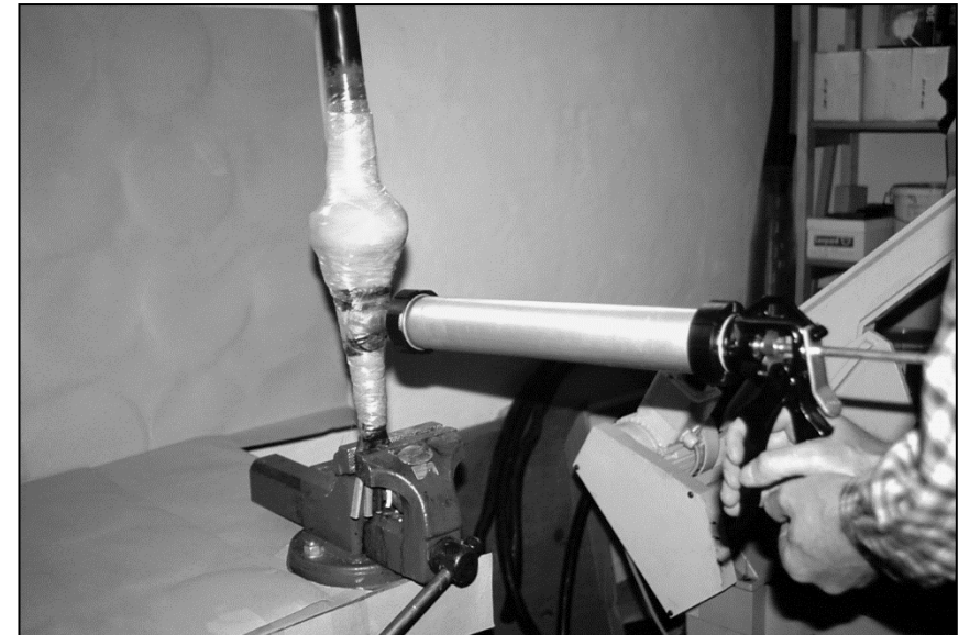
Verguss der Spritzmuffe.
