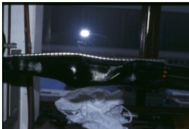
Bild 4 Schrupfabzweigmuffe mit «Hosenklammer» als Abdichtung zwischen Durchgangs- und Abzweigkabel
