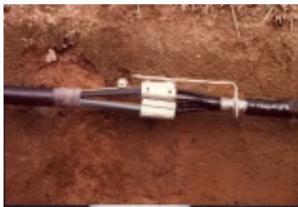
Bild 1 Kabelübergang NAKBA (Massekabel Papierölsolation) auf NAYY-(XLPE-) Kunststoffkabel vor Anlegen der Muffenschale
