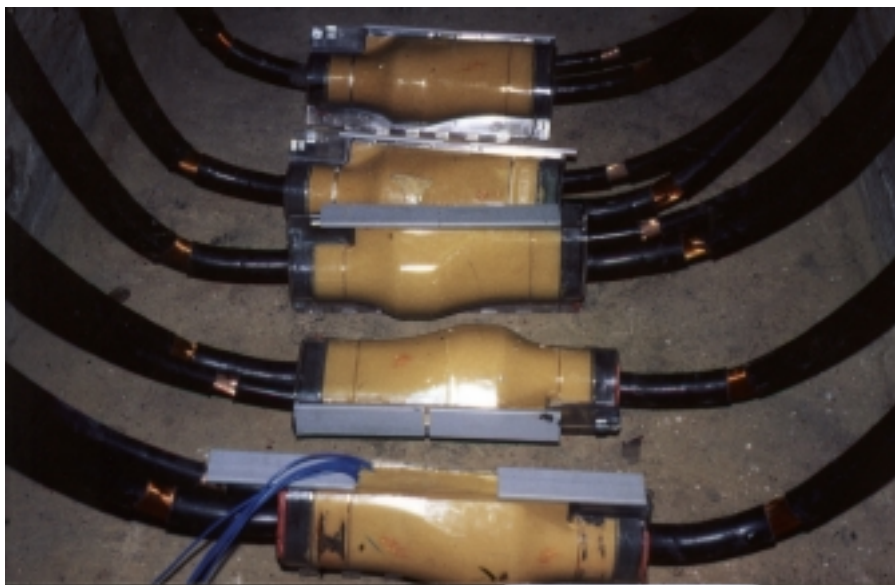
Bild 3 Niederspannungs-Abzweigmuffe AM-Kabelmuffe AVM 140/420: Kabel N(A)YCWY 4150 mm 2 und Durchgangskabel auf N(A)YCWY 4x95 mm 2 Abzweig
